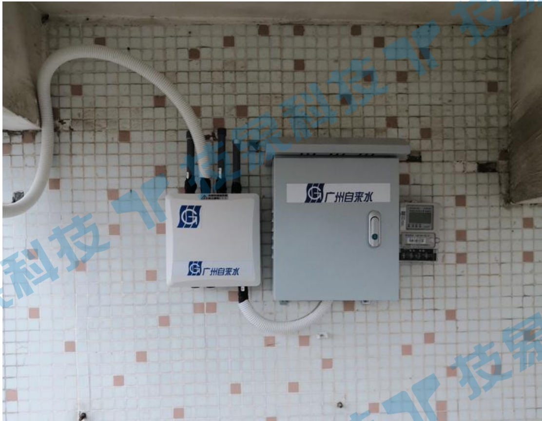
图 44 试点项目 TPUNB 网关架设图
